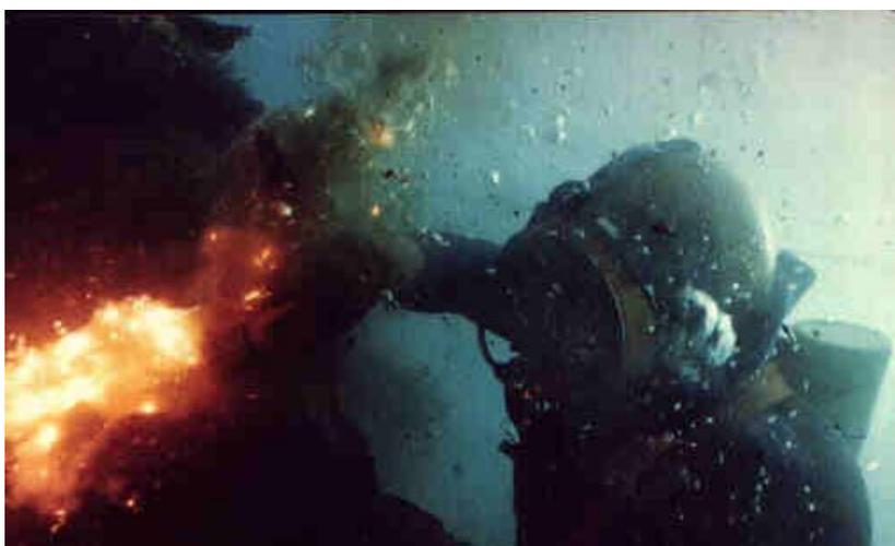
**Fig 20: Es posible cortar y fundir aún sobre piezas con incrustaciones.**
