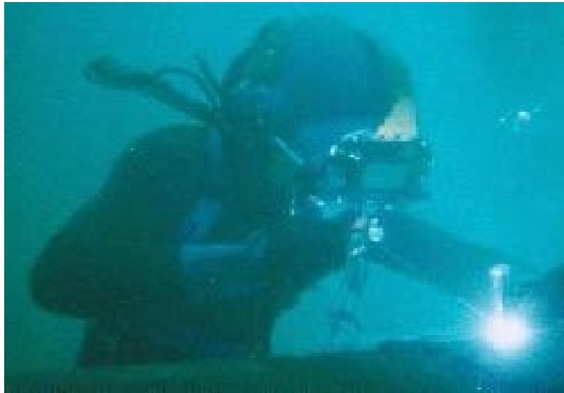
**Fig 32: Corte por arco metálico.**
