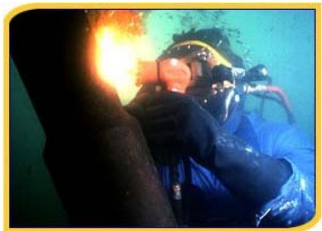
Fig 18: Buzos realizando operaciones de corte arco-O2 subacuático.
