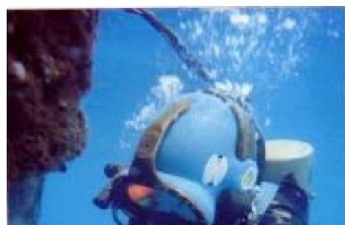
**Fig 27: El buzo sostiene el extremo del electrodo para estabilizar el corte.**
